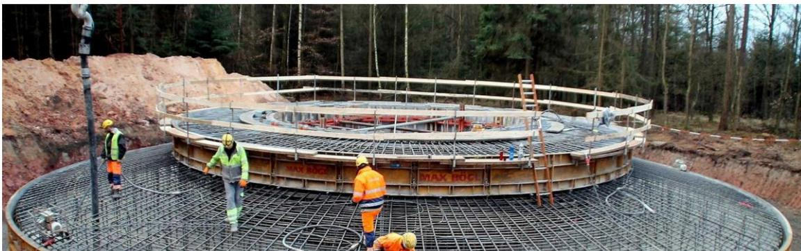
**Bild 5: Fundament für eine Windkraftanlage.**
